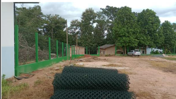
Foto 01: Registro fotográfico do muro da instituição. Fonte : Edilaine Sementino
